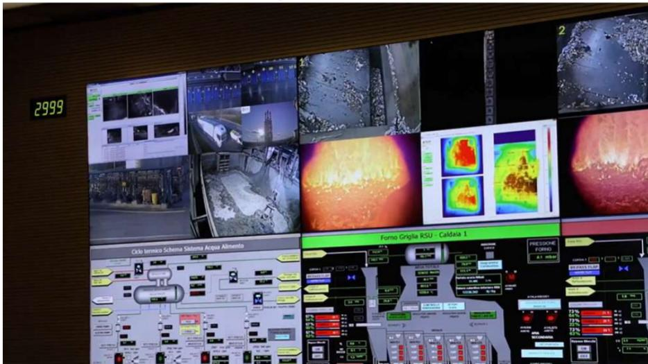
Figura 3 – Quadro di controllo con le immagini del forno e della fiamma
